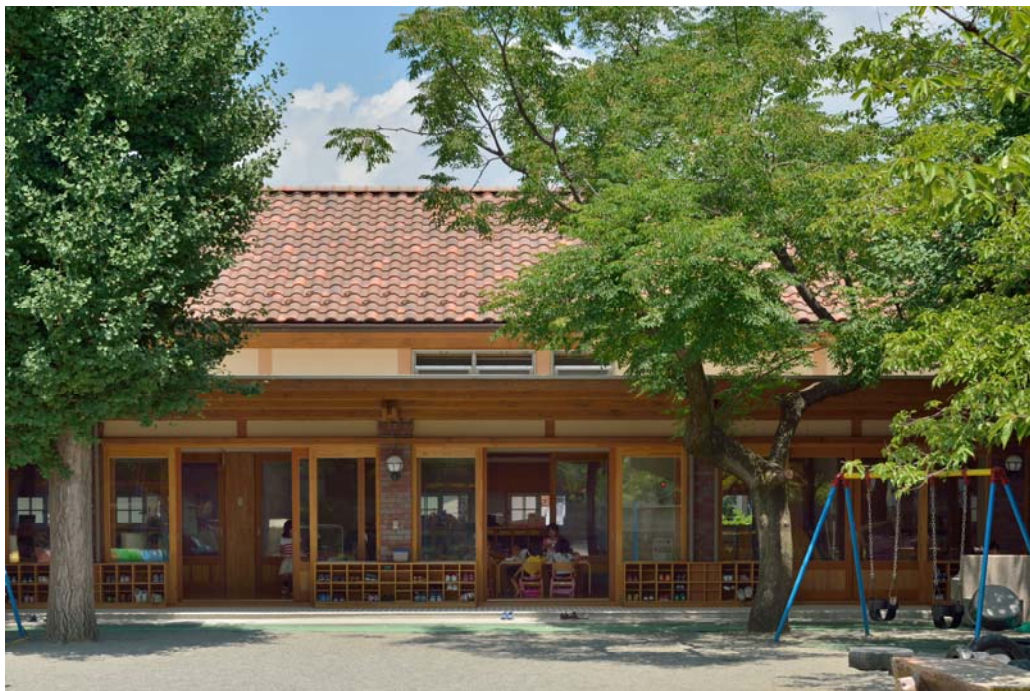
南側からの全景
