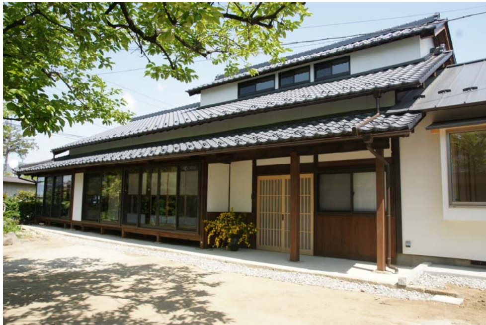
南側からの全景
